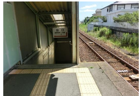
図-26 天浜線ホーム(地下道入口)
