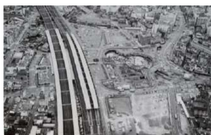
図 2-3 国鉄高架化事業完成の頃
