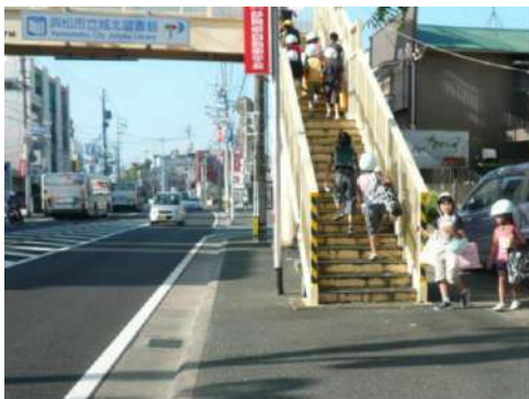
図 7-37 横断歩道橋で急に狭まる歩道
