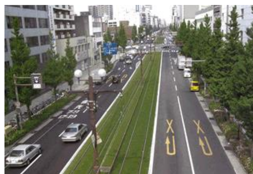
図 4-13 鹿児島市芝生軌道(延長 2.8km)
