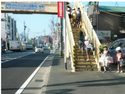
図 7-37 横断歩道橋で急に狭まる歩道
